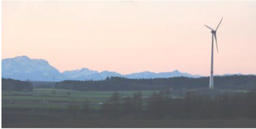
Auf die Perspektive kommt es an: Windrad bei Mammendorf höher als die Zugspitze?
