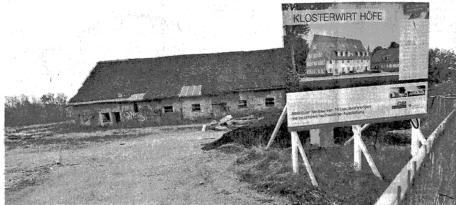
Die maroden Gebäude in Grafrath sollen durch 16 „Luxuswohnungen“ in den künftigen „Klosterwirt-Höfen“ ersetzt werden. FOTO: GÜNTHER REGER
