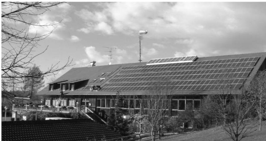
Photovoltaikanlage: Strom von der Sonne: im Herbst letzten Jahres wurde eine Photovoltaik-Anlage auf dem Dach des Bürgerstadels mit ca. 200 qm in Bürgerbeteiligung in Betrieb genommen.
