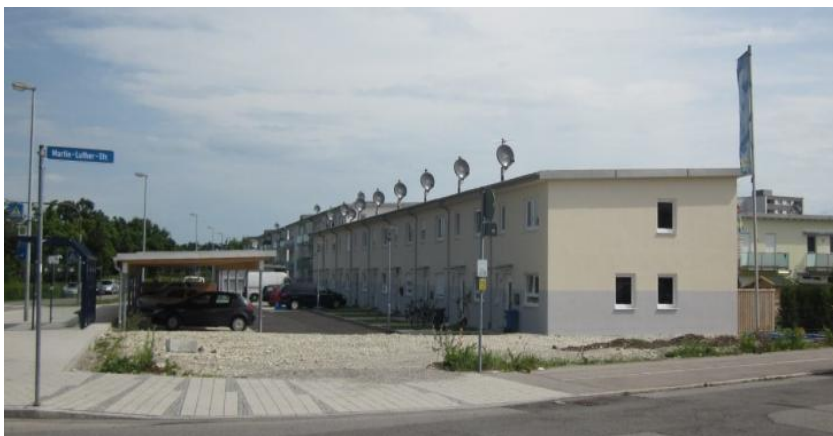
Fantasielose Reihenhaus-Anlage der Real-Treuhand in FFB: Satellitenschüsseln auf Bauklötzchen
